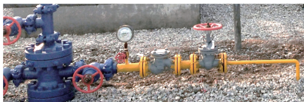
图1 套管气回收井口
